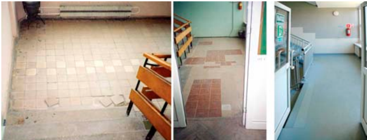
Лестничные площадки здания
